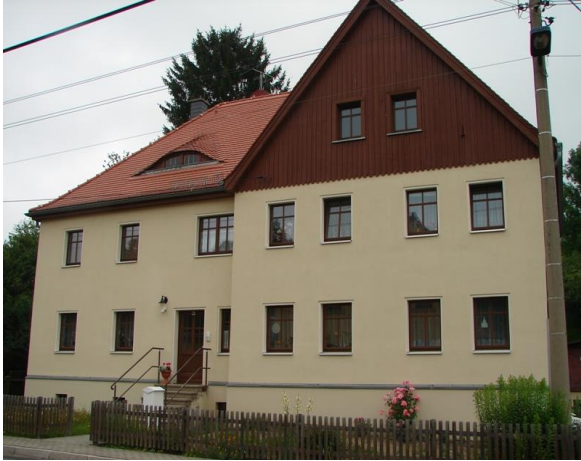
Bild 2: Straßenansicht aus Richtung Süden
