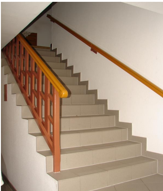
Bild 4: Treppe ins Obergeschoss
