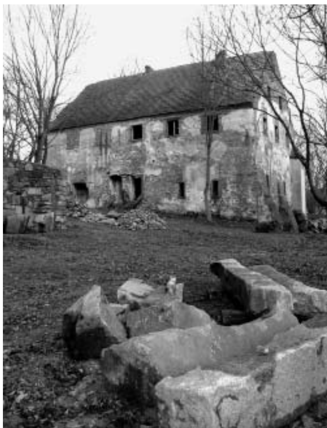
Madlen und Matthias Donath werden den Westflügel des Wasserschlosses des Oberen Rittergutes mit Hilfe des ILE-Programmes sanieren und zu ihrem Hauptwohnsitz ausbauen.
