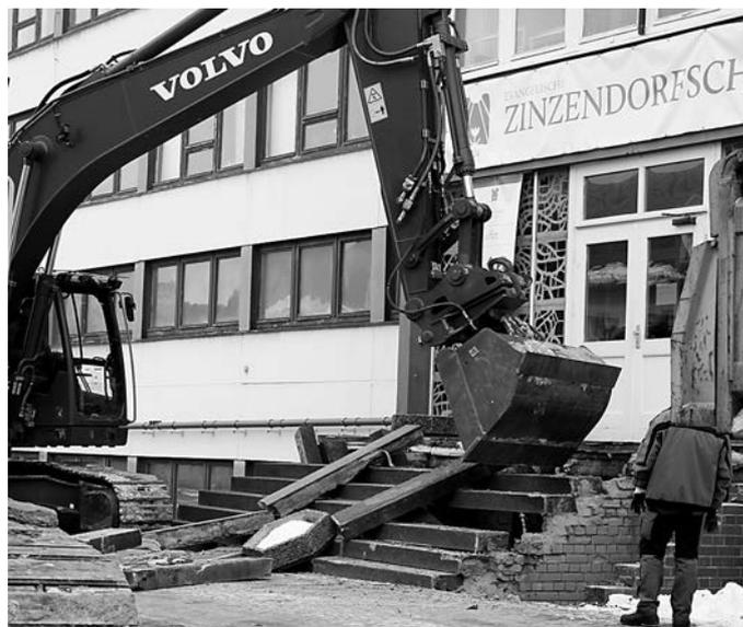
Zur Vorbereitung der Baufläche wurde zunächst der letzte Schnee beräumt sowie die Treppe zum Haupteingang zurückgebaut. Die Bodenplatte unseres neuen Schulhauses wird von 98 Bohrpfehlen getragen, die mit einem 22,5 m hohen Spezial-Bohrgerät gesetzt werden. Mit Spannung und Interesse konnten wir diese Arbeiten in den Winterferien verfolgen. Dank des großen Einsatzes der Spezialtiefbaufirma waren die Bohrungen deutlich schneller als geplant bereits Ende der Ferien nahezu abgeschlossen.
