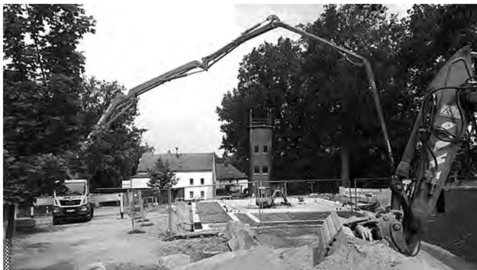
Die Bodenplatte (mit Ausnahme der Fahrzeughalle) wurde am 19.7. gegossen.
