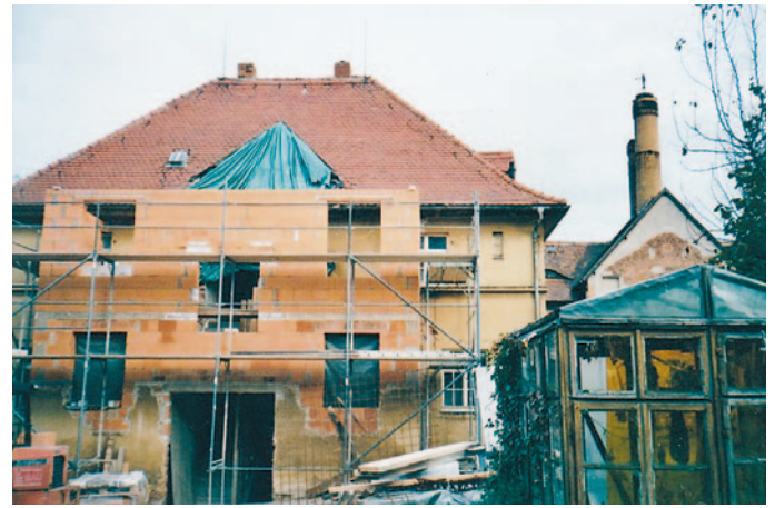
Die Baustelle im November 2010
